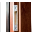
5. protiplech horného zámku TYP P
