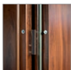
2. pevné bezpečnostné trny (B) TYP P
